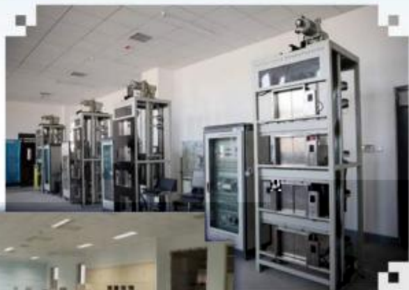
智能电梯安装调试 维护训练场所
